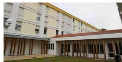
Le groupe scolaire Saint-Jacques-de-Compostelle a récemment inauguré le Centre d'études supérieures catholiques des Landes. ISABELLE LOUYER / SO
